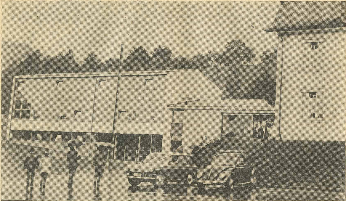
Der Turnhallenneubau von Wil, an den sich rechts das renovierte und ausgebaute Schulhaus anschliesst.
